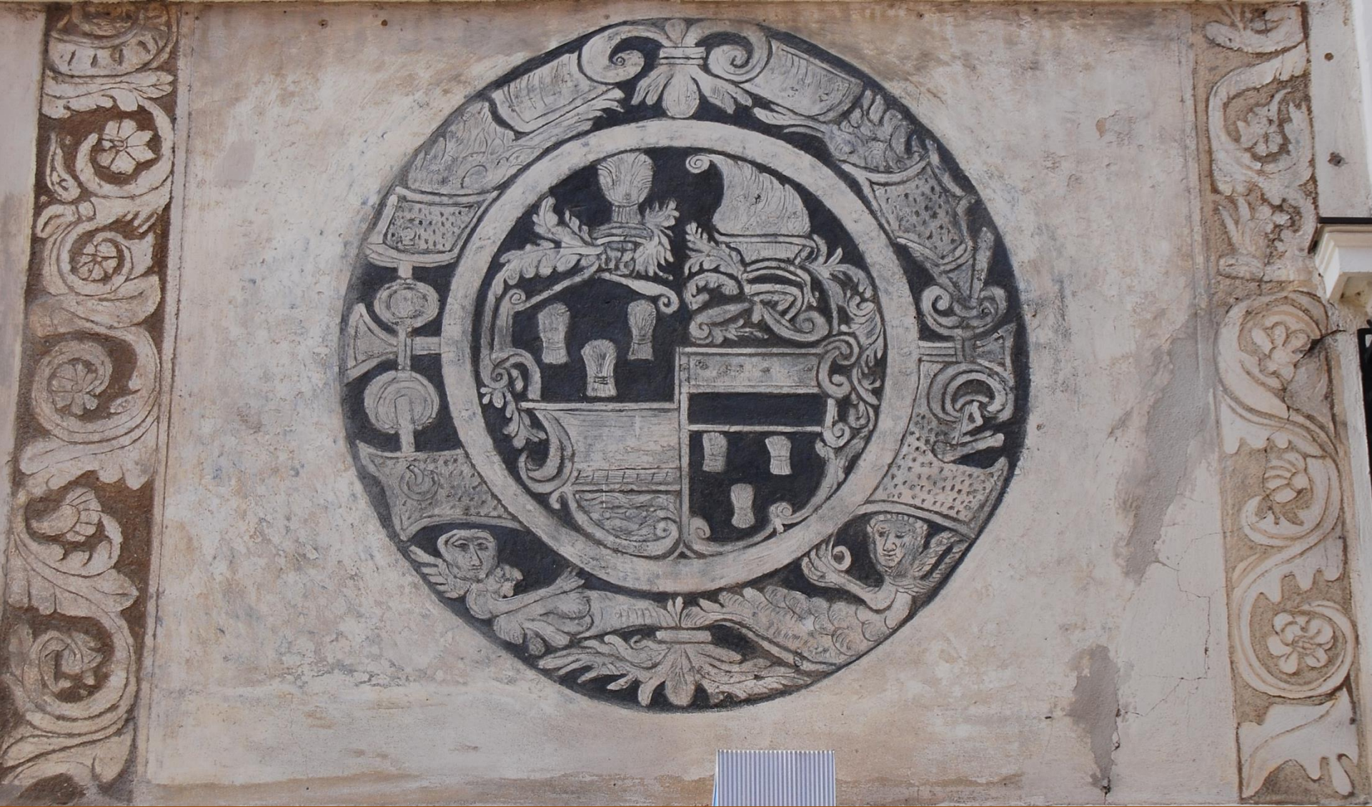
Fachada en Horn, Austria Esgrafiado embutido combinado con esgrafiado con acabado en cal
